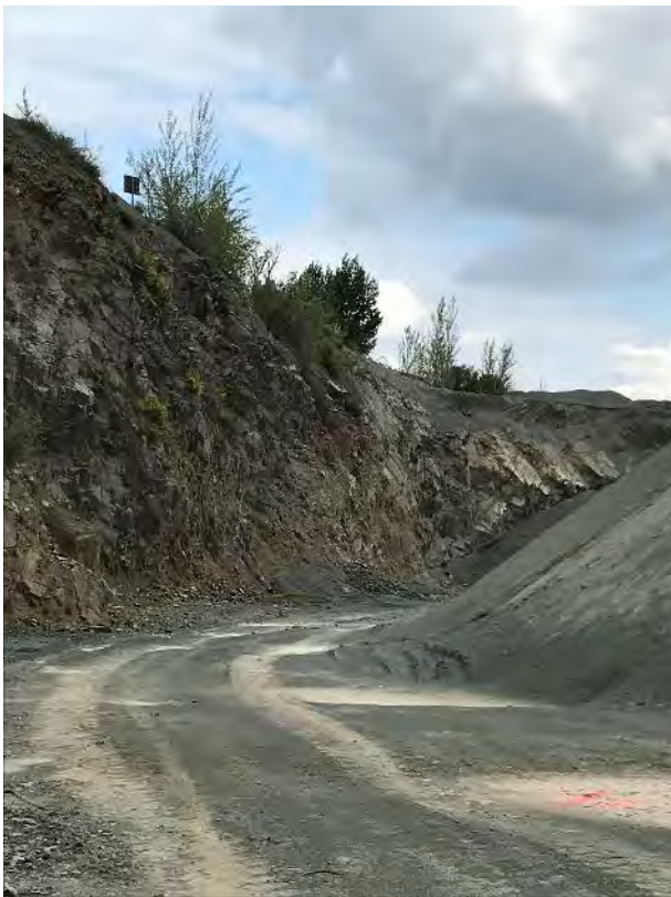
Observation globale du front Nord de la zone de stockage à proximité SBL08
