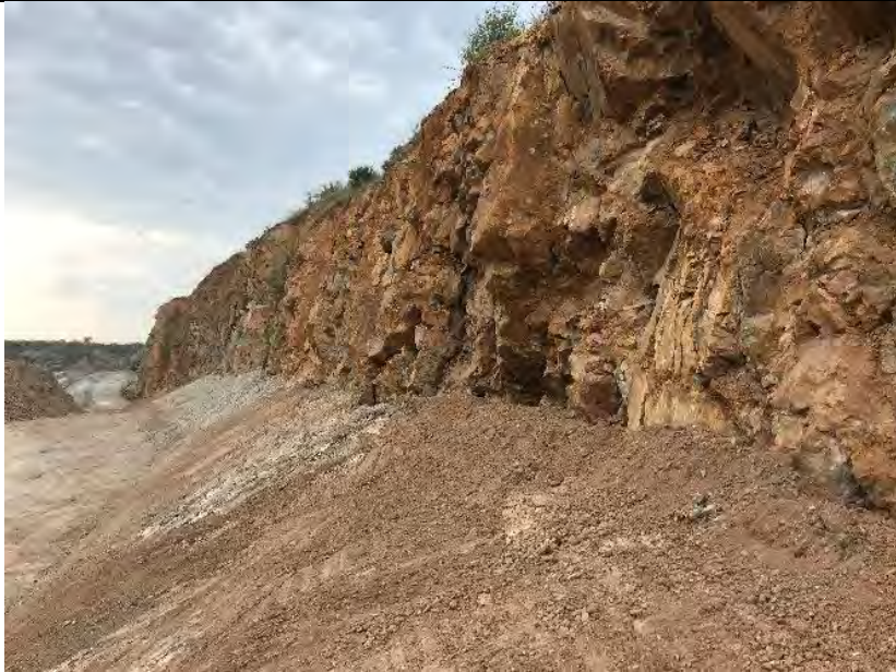
Observation depuis BSL08 = zone altérée faillée constituant le couloir de faille NNW-SSE
