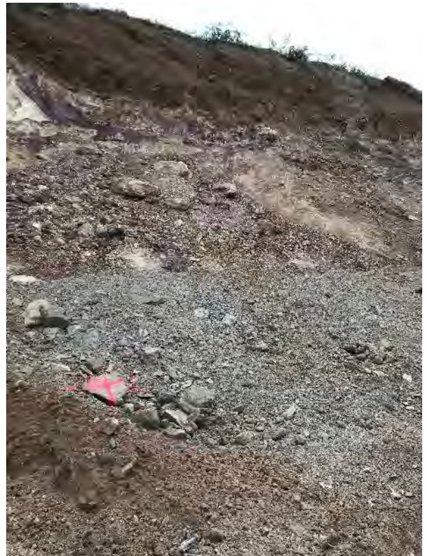
Observation BSL06 = Altération violacée des schistes (faille ?)
