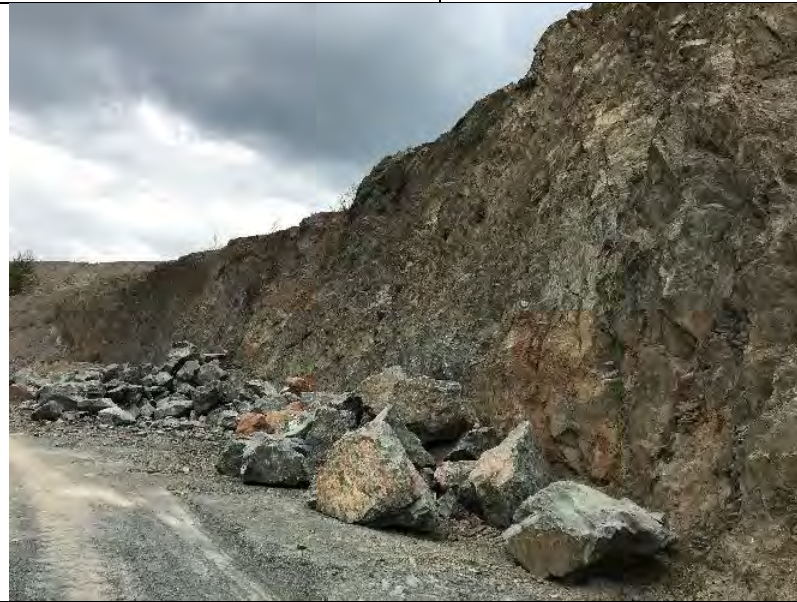
Observation du front Nord depuis SBL09
